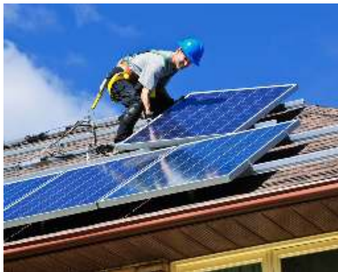
Рисунок 1 – Установка солнечных панелей
