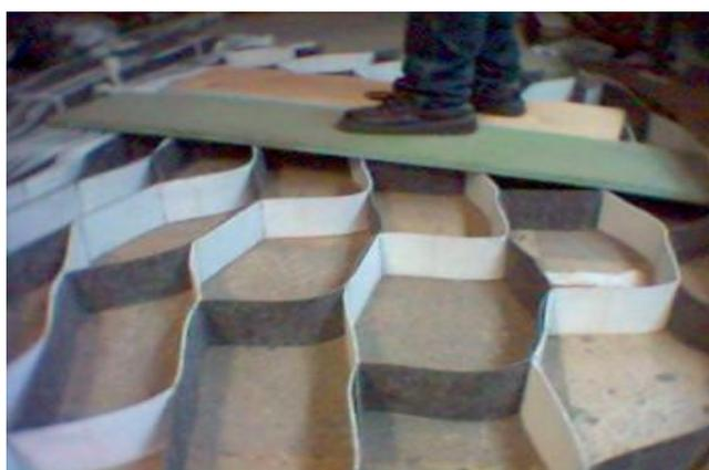
Рисунок 3 – Геотекстиль в растянутом состоянии
